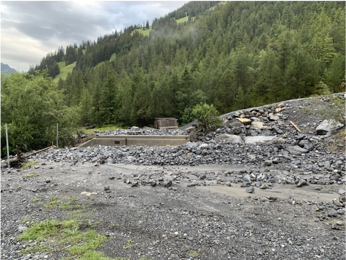
Das Tyroler Wehr nimmt grossen Schaden, die Geländer und die Fundamente der Brücke sind beschädigt (Sommer 2021).
