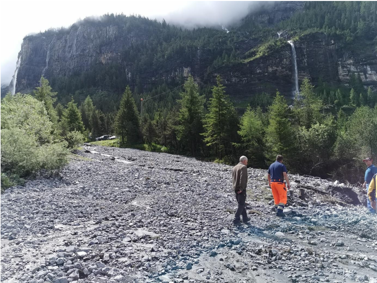
Blick zwischen der Transportbahn Doldenhornhütte und untere Skibrücke / Tyroler Wehr. Inspektion des Schadenplatzes durch den Schadenplatzkoordinator der Gemeinde, Fritz Rösti.
