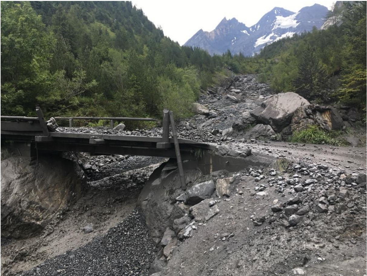
Rinderstutzbrücke im Juli 2018.
