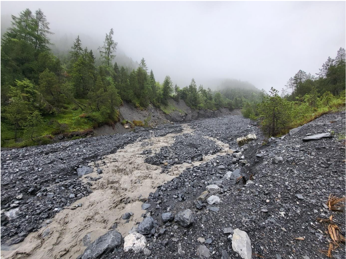
Bachlauf oberhalb Tyroler Wehr / untere Skibrücke. Der seitliche Damm (rechts im Bild) wurde wieder neu aufgeschüttet, um die Skipiste und die Leitungen zu schützen.
