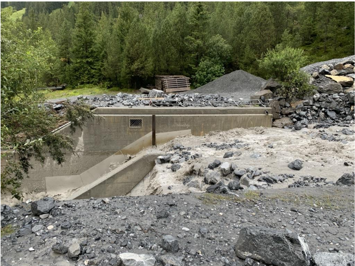
Das Tyroler Wehr nimmt grossen Schaden, die Geländer und die Fundamente der Brücke sind beschädigt (Sommer 2021).
