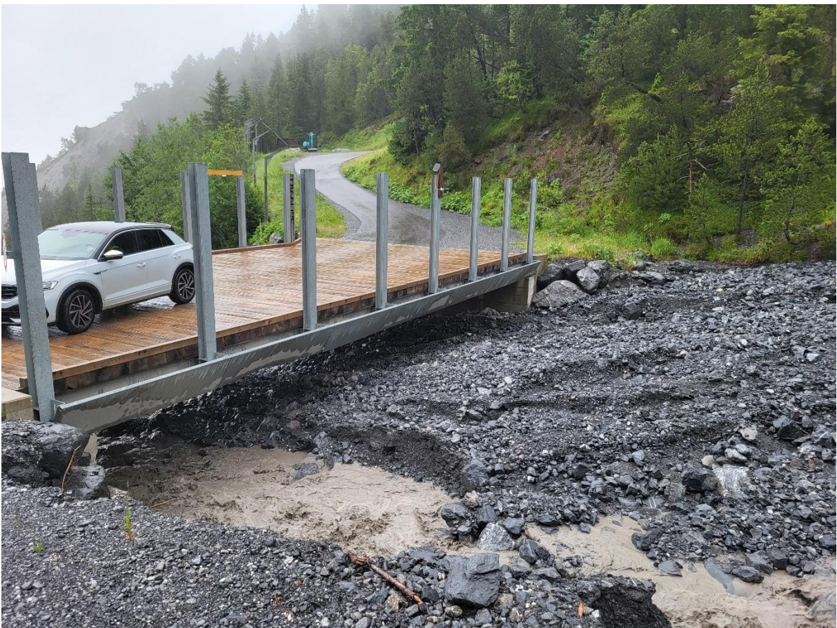
Viel Geschiebe im Bach. Obwohl die Skibrücke beim Wiederaufbau im Herbst 2018 um 8 Meter erhöht wurde, bleibt wieder nicht mehr viel Platz.
