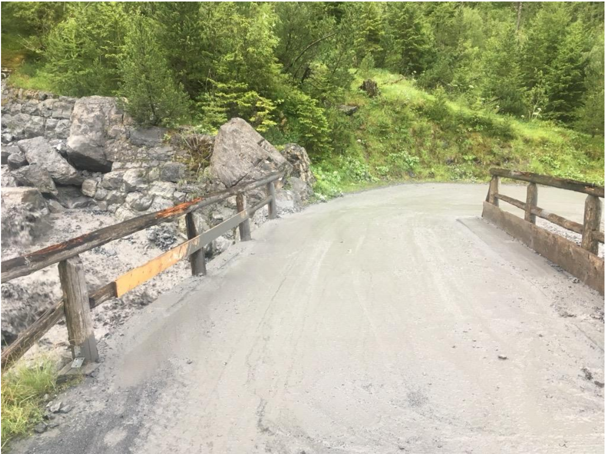
Reparatur Rinderstutzbrücke (Juli 2018).
