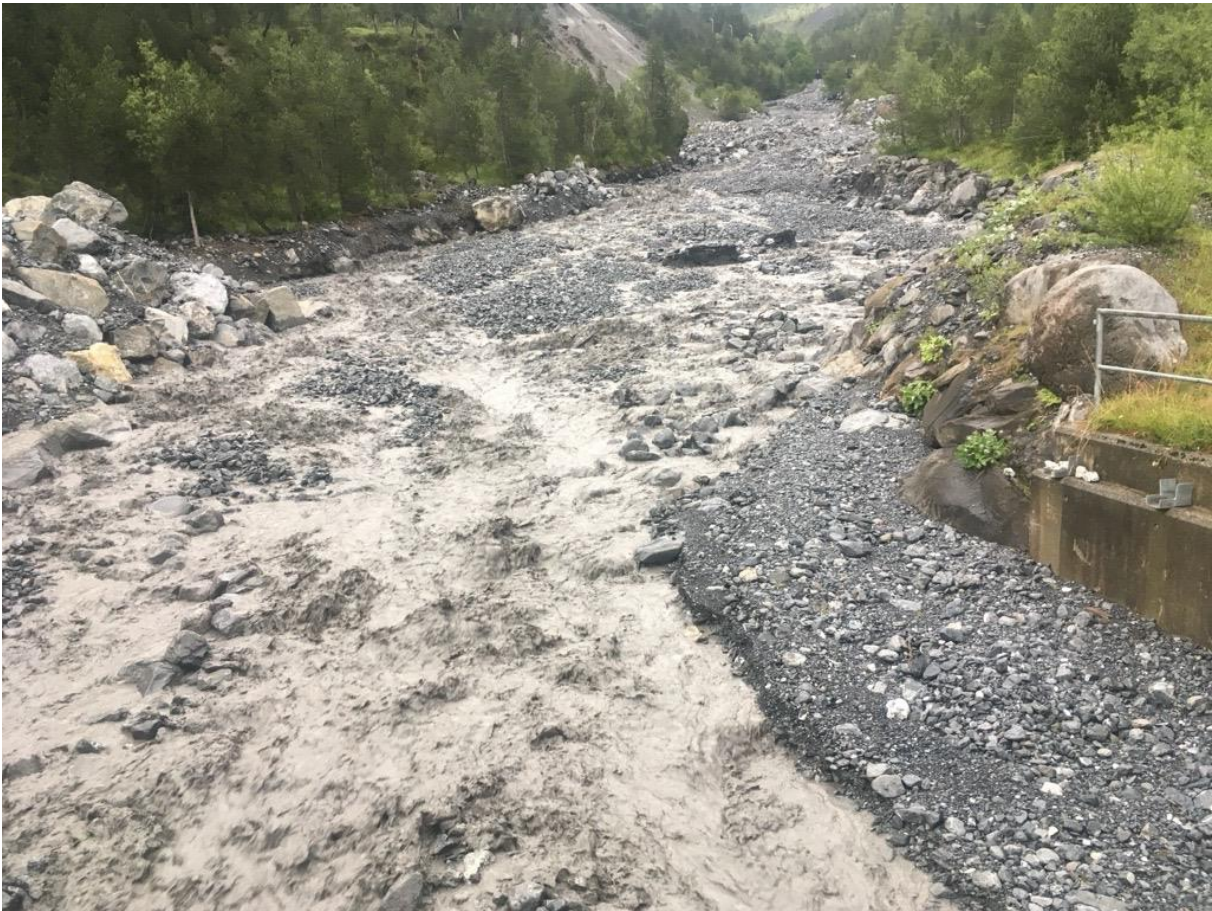
Tyroler Wehr / Wasserfassung LWK und untere Skibrücke. Entscheid, dass die Skibrücke im Frühling abgebaut werden soll, sowie auch der Fussgängersteg.
