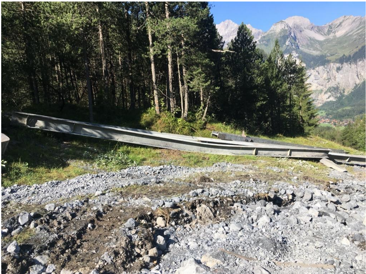
Die Träger der alten Skibrücke wurden deformiert und konnten nicht wieder verwendet werden.
