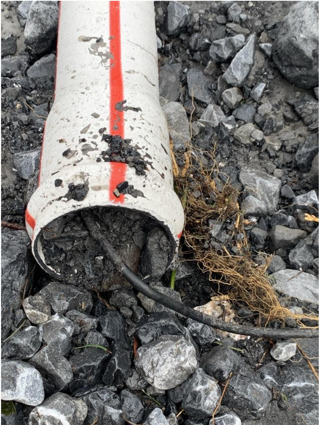
Das Glasfaserkabel (Swisscom) ist freigelegt.
