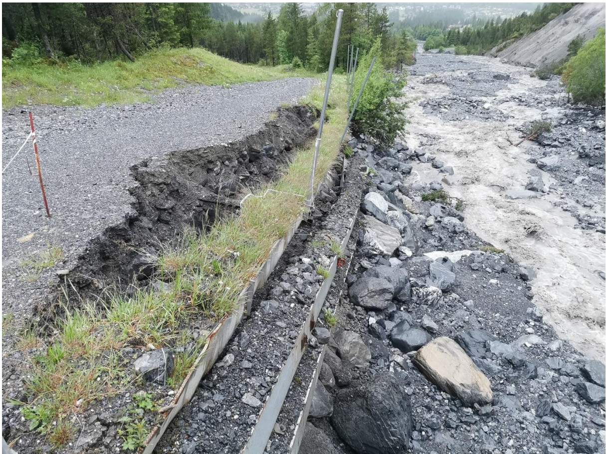
Ein starkes Gewitter mit einem sehr kleinen Murgang Ereignis beschädigte die Fundamente der Skibrücke. Diese wurde wieder repariert.
