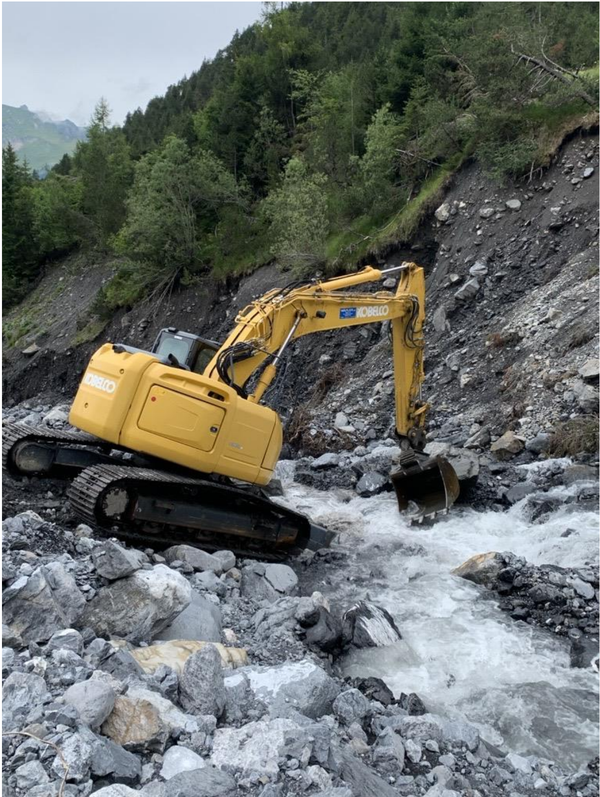
Korrektur des Bachlaufs nach Rücksprache mit dem Kanton und der Schwellenkooperation.
