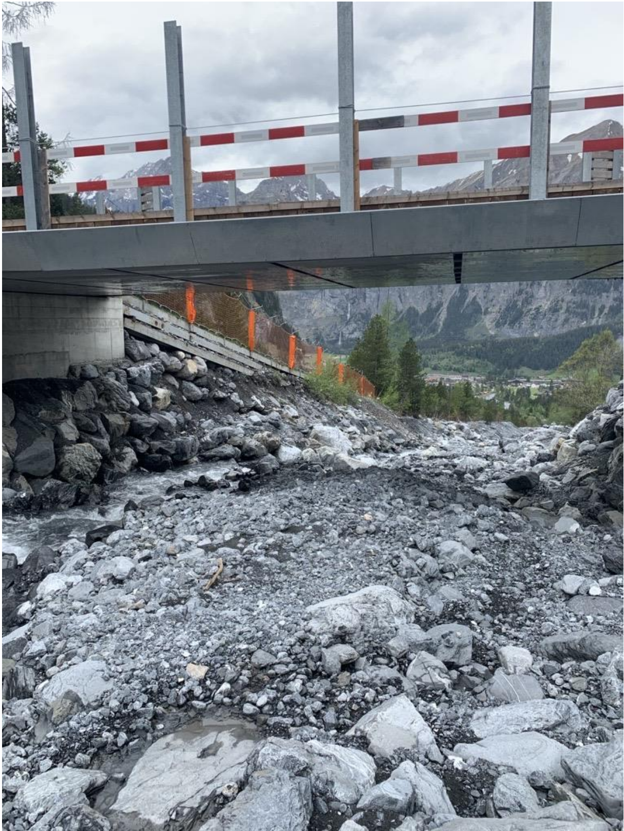
Zum Schutz der Brücke (weniger seitlicher Widerstand) wurden die Geländer entfernt.
