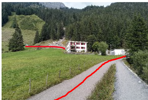
Abbildung 26: Die künftige Erschliessung folgt im unteren Teil beim Kraftwerk Zilfuri der bestehenden Strassenführung. In Rot: Linienführung.
