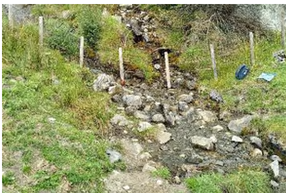
Abbildung 25: Zielfuhrebächli, welches die bestehende Strasse unterquert.
