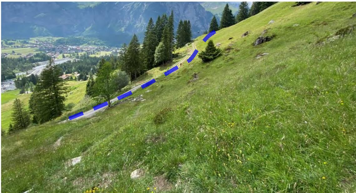
*Abbildung 11: Abgang der Erschliessung von der bestehenden Strasse. Beginn der TWW Standorte. Blau gestrichelt: Neue Erschliessungsstrasse. Foto B. Käufeler, 16.06.2022.*
