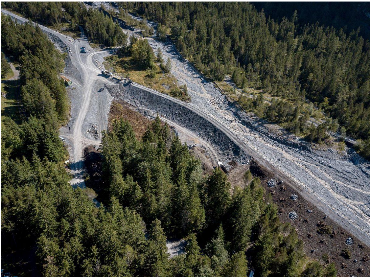
Schutzmassnahmen am Oeschibach: Der Leitdamm im Zilfuri, hier im Herbst 2021. Foto: Karin von Känel
