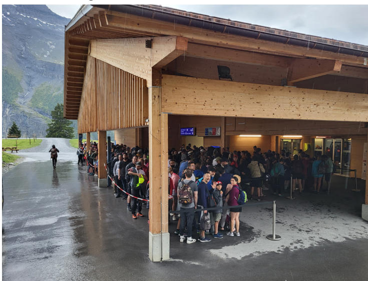
Witterungsschutz bei der Bergstation
