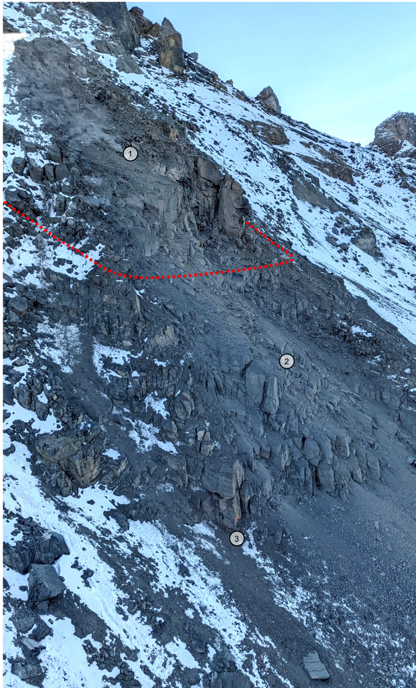
Abbildung 18: Aufnahme des Frontbereiches der sekundären Felsrutschung (Annotation 1) nach den Sturzereignissen von Ende September 2022 (Aufnahmedatum 04. Oktober). Rot gestrichelt angedeutet ist die Gleitfläche der Felsrutschung. In der Transitzone unterhalb des Ausbruchgebietes (Annotation 2) wurde weiteres Material mobilisiert. Annotation 3 markiert den Standort des bisher unbeschädigten Reflektor 72. Reflektor 81, bei Annotation 4 ausserhalb der Aufnahme gelegen, wurde bei den Abstürzen verschüttet. Die durch die Aufnahme abgedeckte Terrain-Höhendifferenz im Vordergrund entspricht gut 100 m.
