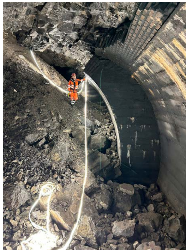
Begehung des Sackstollens im Dezember 2025
