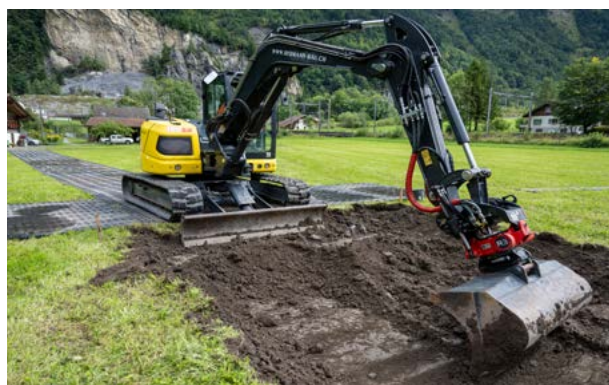
Einsatz von Bodenschutzmatten bei Baggerschlitz im September 2025
