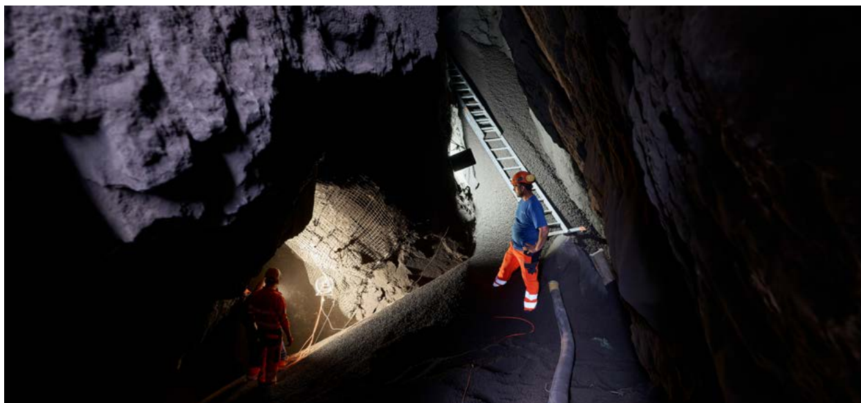
Einbringen des Füllmaterials mit Schläuchen im Juni 2025
