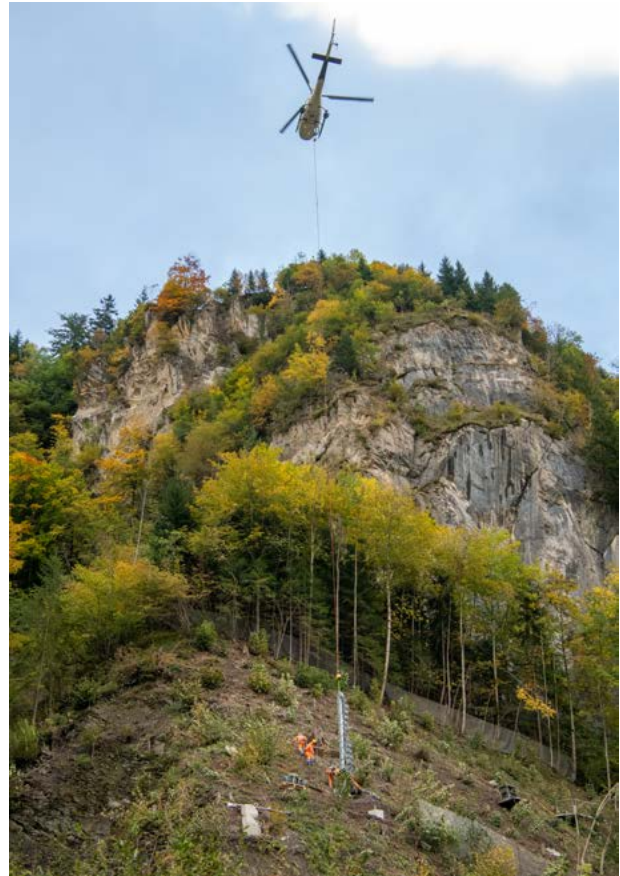
Montage von Steinschlagnetzen unterhalb der Fluh im Oktober 2025
