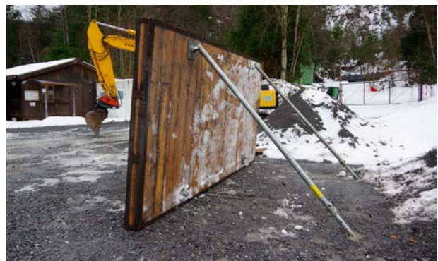
Test zur Anwendung von Splitterschutzwänden im Januar 2025
