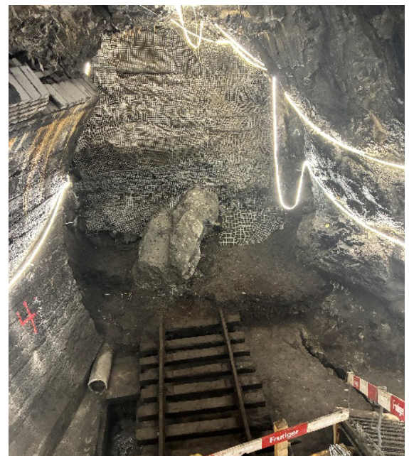
Sondiergrabungen im Sackstollen bis zu den Gleisen
